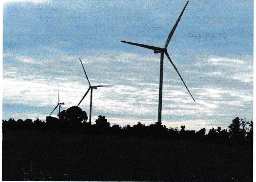
La rotation des éoliennes d'Andilly est régulièrement arrêtée pour éviter à la Coopec de perdre de l'argent. Y.P.
